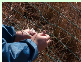
ネットの補修状況
