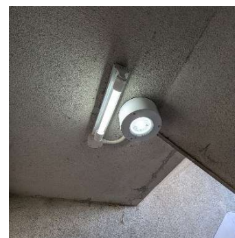
[共用部(階段室)の照明をLED化]
