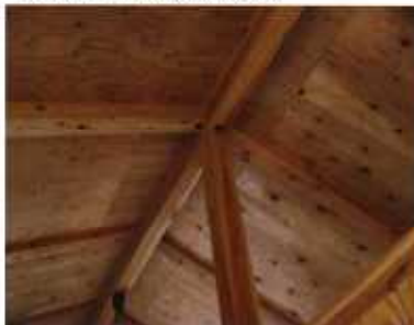
屋根パネル仕上部
