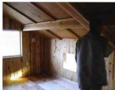
二階母屋下り部・居住空間としては十分な断熱を確保
