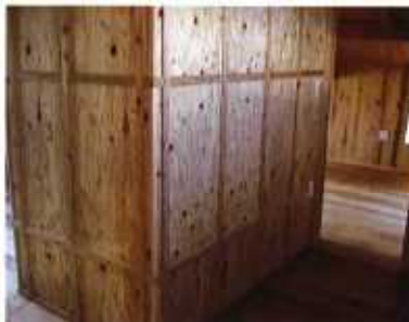
二階の壁仕上げ(杉合板表し)
