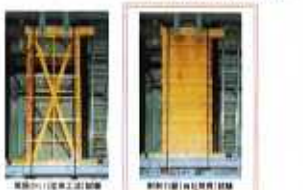
新開発フィットウォール工法による耐力壁の施工様子(1)
