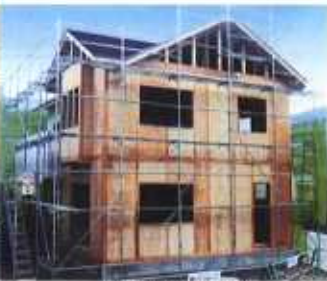
フィットウォール工法による耐力壁の施工様子(2)
