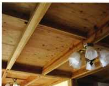
一階天井仕上げ(二階の杉合板の床表し)
