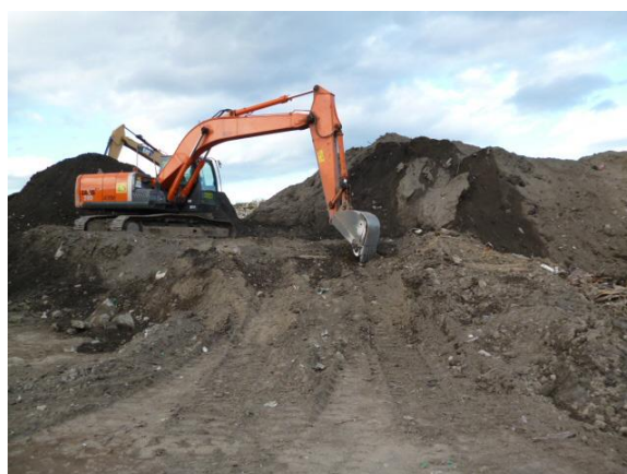
東日本大震災(平成23年3月)
