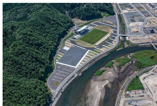
スタジアム竣工
