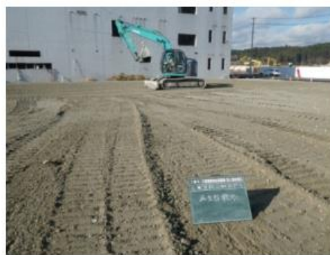
敷均し・転圧状況
