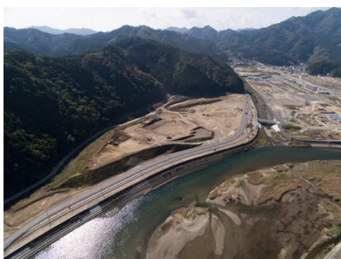
釜石鵜住居復興スタジアム造成状況
