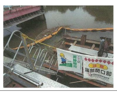
指摘事項:足場の最大積載荷重を定め、掲示すること。 解 説:安全衛生規則第562条(最大積載荷重)
