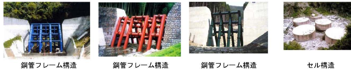
写真1. 代表的な透過型鋼製砂防堰堤の事例
