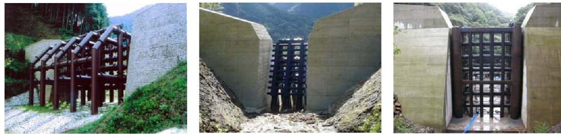
写真 3. 土石流区域における部材間隔を狭めるタイプの施工事例
