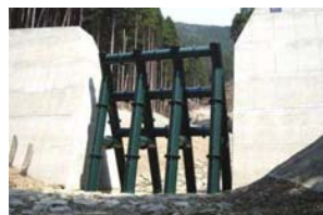
鋼管フレーム構造
