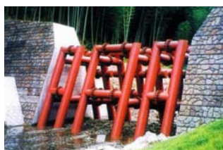
鋼管フレーム構造
