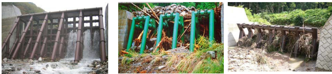
写真2. 土石流・流木捕捉事例
