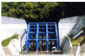
鋼管フレーム構造
