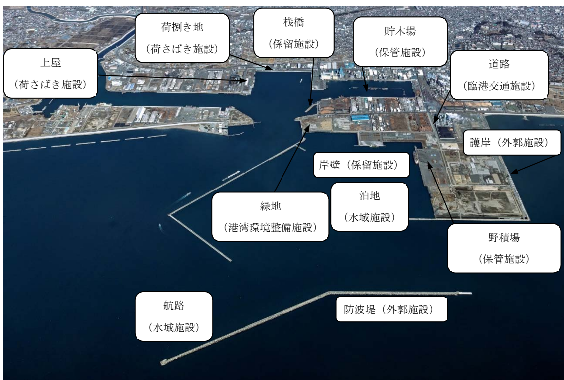
参考図：代表的な港湾施設（仙台塩釜港（石巻港区））
