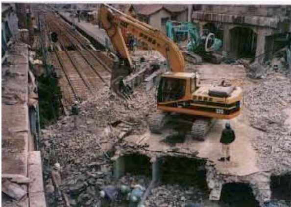
写真. 斜橋の落橋(兵庫県南部地震)
