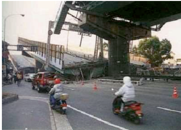
写真. 単純桁形式の高架橋の落橋(兵庫県南部地震)
