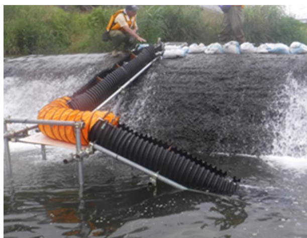
図2 ハーフパイプ式簡易魚道
