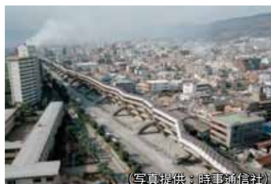
阪神・淡路大震災による高速道路の倒壊
