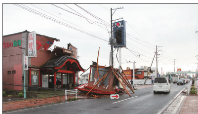
台風による ( ) で 店舗の二階部分が落下
