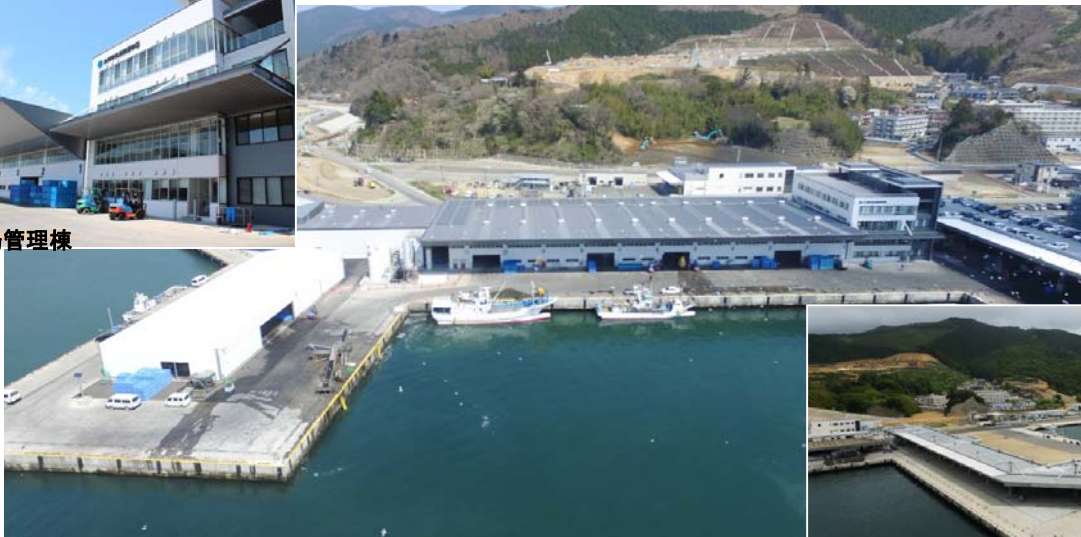
東棟荷さばき所
