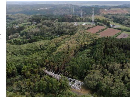
鉄塔設備の倒壊（君津市）
