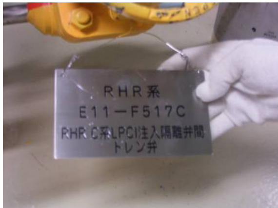
<弁への銘板の取り付け>
