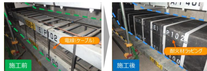
耐火ラッピングの施工例
