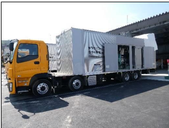
ガスタービン発電機(A)の外観
