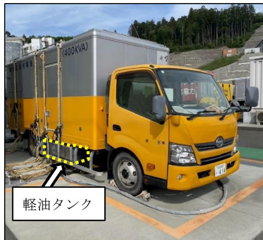
電源車の外観
