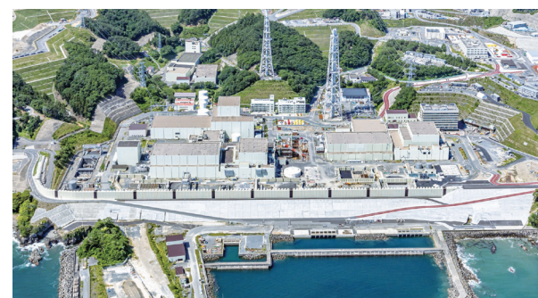
新規規制基準に適合した防潮堤など女川原子力発電所の全景 (バスに乗りして見学)【東北電力提供】
