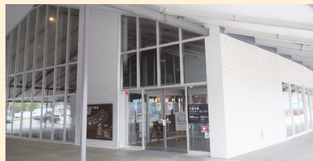
センターの外観
