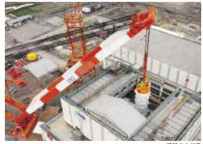
建設中の状況
