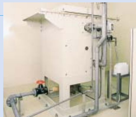
放水口モニター(2号機)
