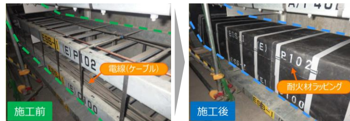
耐火ラッピングの施工例
