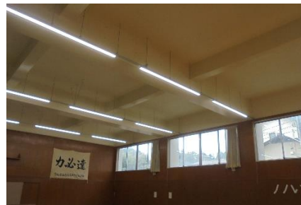
柔剣道場天井改修（完成）
