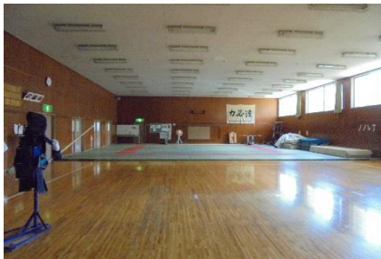
柔剣道場天井改修（着手前）
