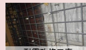
耐震改修工事 施工状況
