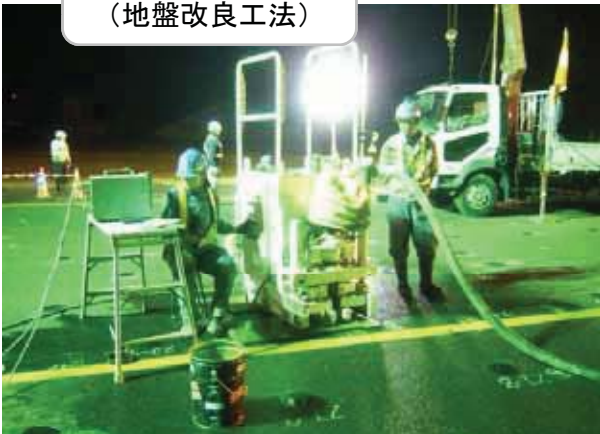
耐震整備工法 (地盤改良工法)
