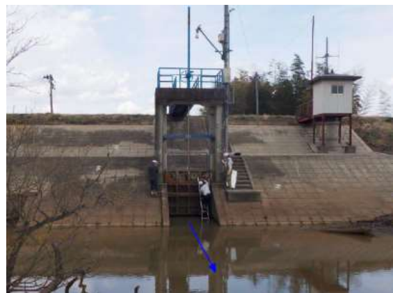
▲施設状況（吐口側）
