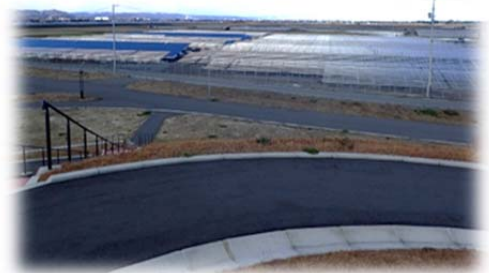
▲吉田東部 2 期地区 太陽光発電施設の様子
