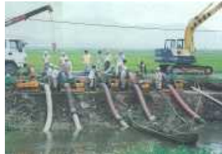
(応急ポンプ設置状況<桃生町>)
