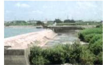
(干上がった鳴瀬川<上川原堰>)
