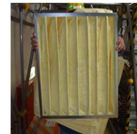
（新品：バッグフィルタ正面（給気入口側））
