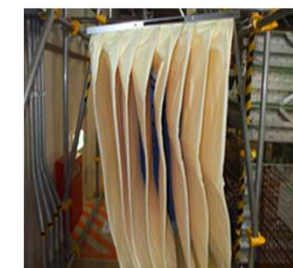
（新品：バッグフィルタ側面（給気出口側））
