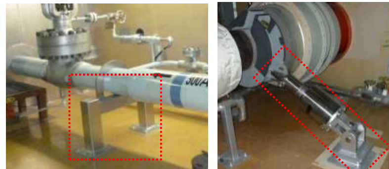
耐震工事の実施状況
