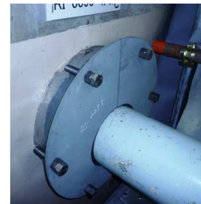
貫通部の止水処理
