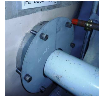
貫通部の止水処理
