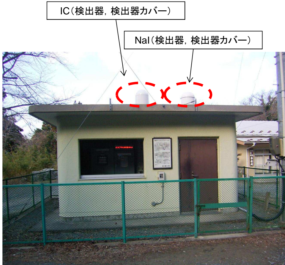
モニタリングステーション (建物, 鉛遮へい体等は既設を流用)
