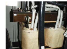
絶縁油を使用しない乾式の変圧器
