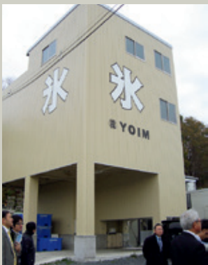
写真:グループ補助金で整備された共同水産加工施設(南三陸町)
