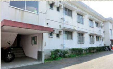
写真:みなし仮設住宅(民間企業の社宅)(仙台市)
