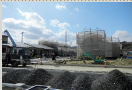
写真：復興交付金で整備中の災害公営住宅(山元町)
