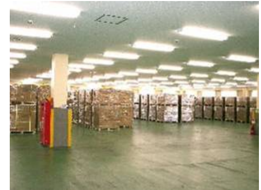
空調機能付き保管倉庫、定温保管
