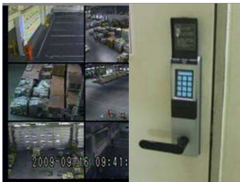
監視モニター・各フロアセキュリティ
