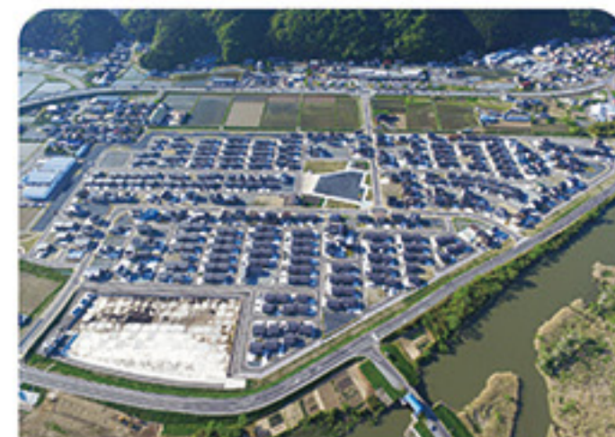
県内全ての地区で造成工事等に着手、住宅等建築工事が可能となりました。(写真：石巻市の二子団地)
