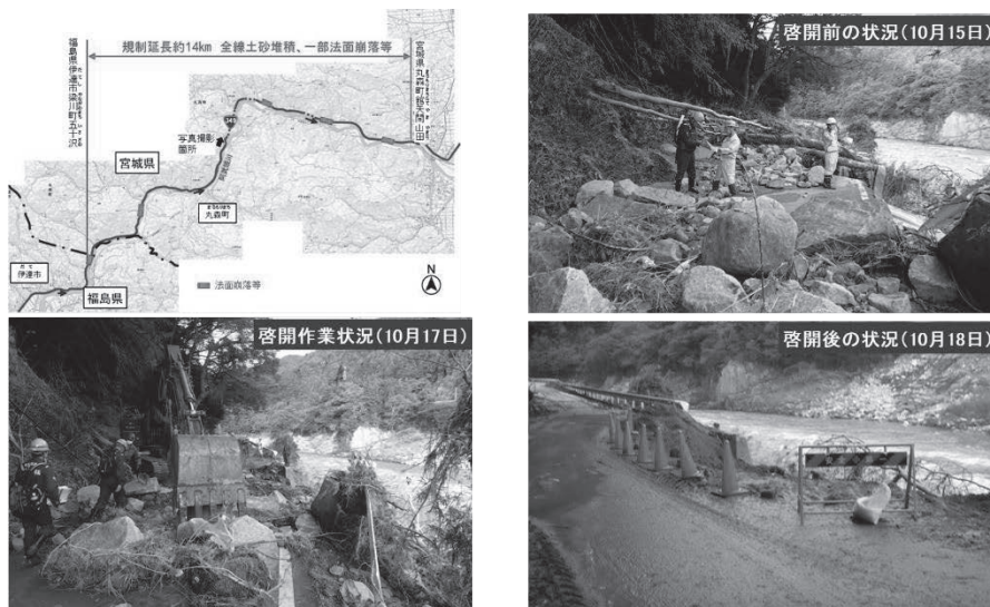
国道 349 号 道路啓開の状況（丸森町）
