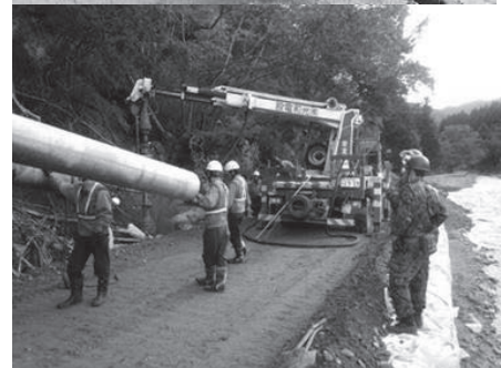
復旧作業の様子
