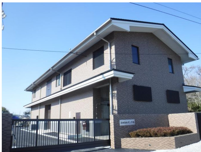
■長田排水区 雨水ポンプ施設
