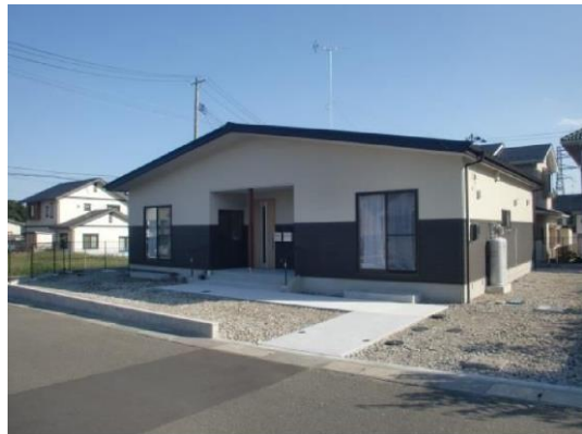
■ 災害公営住宅 (美映の丘地区)
