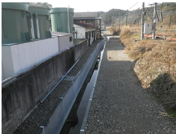
■蛇ヶ崎排水区 排水施設
