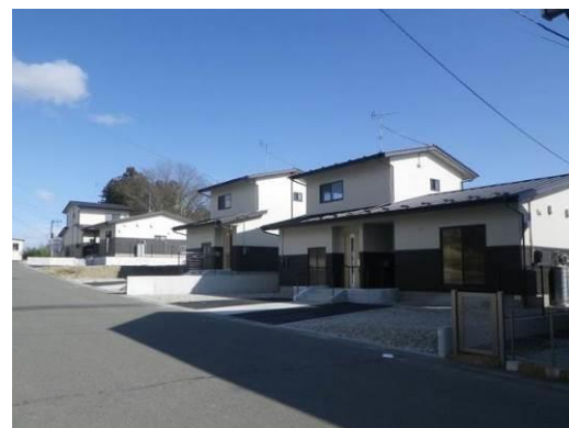
■ 災害公営住宅 (美映の丘地区)
