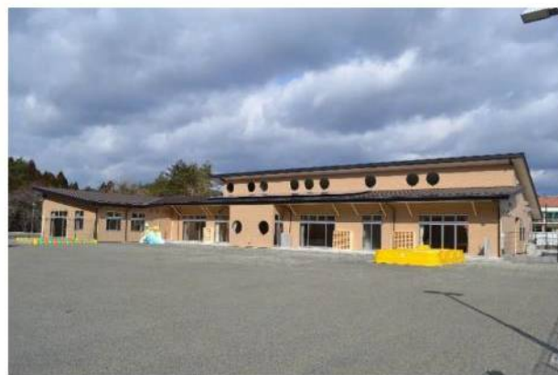
②保育所側からの外観
