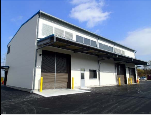
《共同乾燥調製施設整備》
