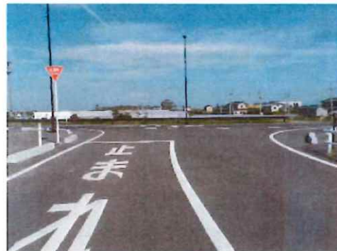
完成④（終点部）
