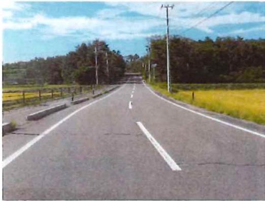
完成⑤（水神沼周辺～起点部を望む）
