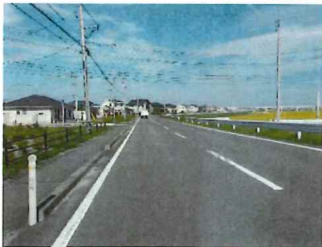
完成①（起点部）
