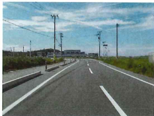
完成②（終点部～県道交差部方向を望む）
