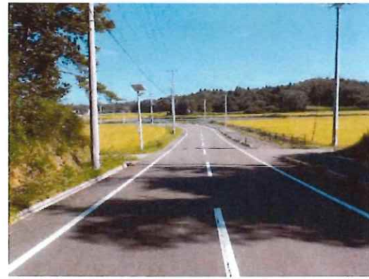
完成⑥（起点部～終点部方向を望む）
