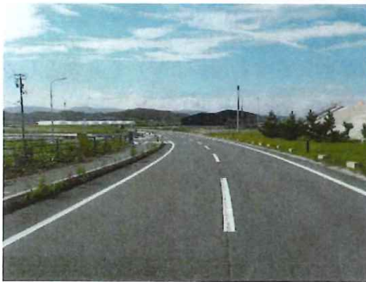
完成①（終点部）※磯浜漁港周辺
