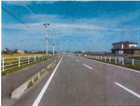
完成③（中間部～終点部を望む）
