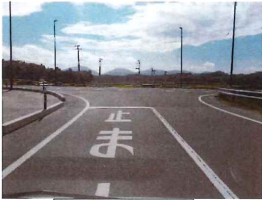
完成③（県道交差部）
