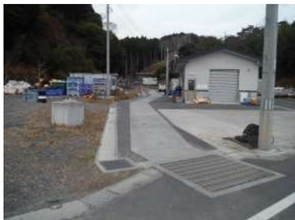
<整備後（集落道）>
