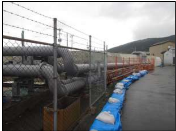
配管の築堤乗り越し状況写真
