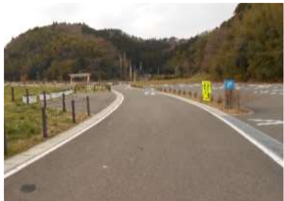
<整備後（集落道）>
