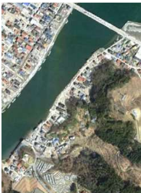
被災後の移転元地
