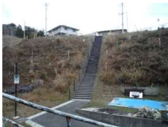
<整備後（避難路）>
