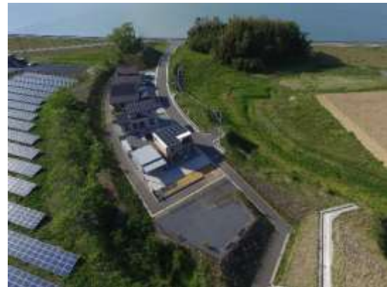
完成した移転団地
