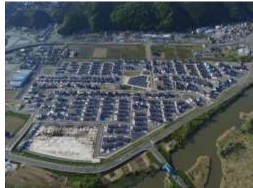
完成した移転団地
