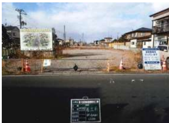
整備前（終点部（東端側））
