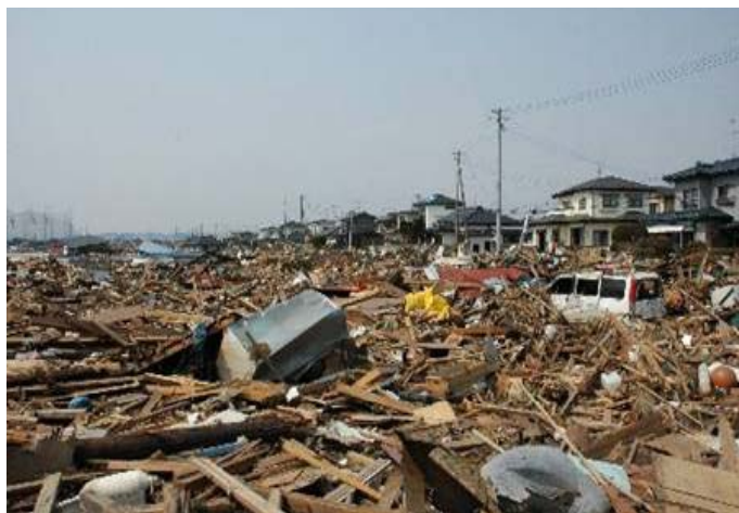
H23.5.20 被災状況
