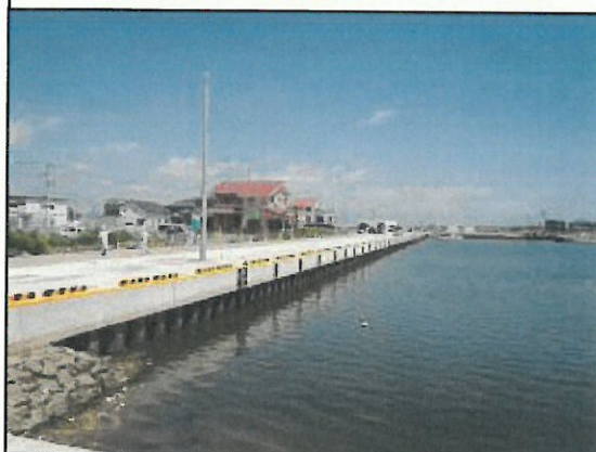
今回完成した物揚護岸 L=170m
