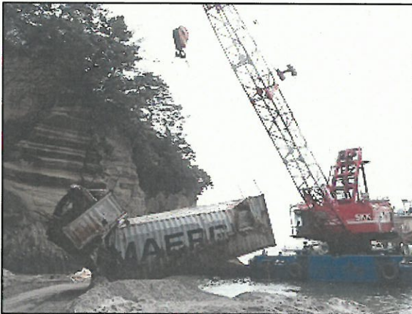
コンテナ撤去作業
