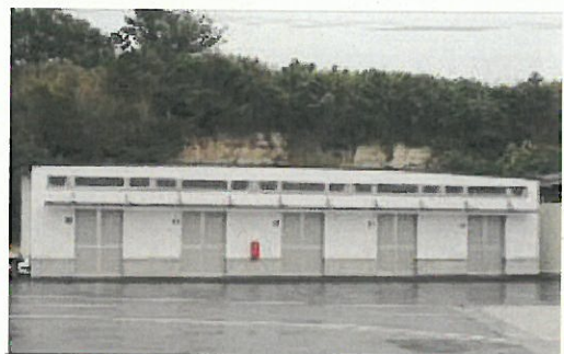
平成24年度事業で整備した漁具倉庫
