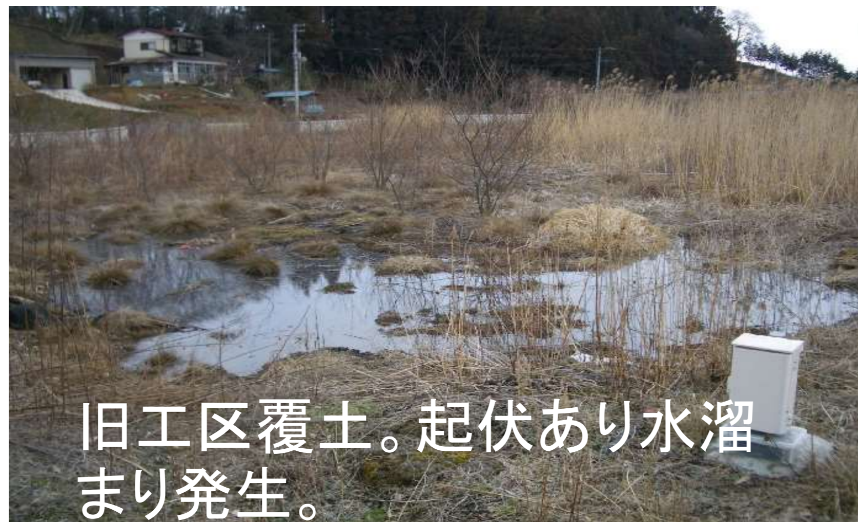
処分場内 覆土
