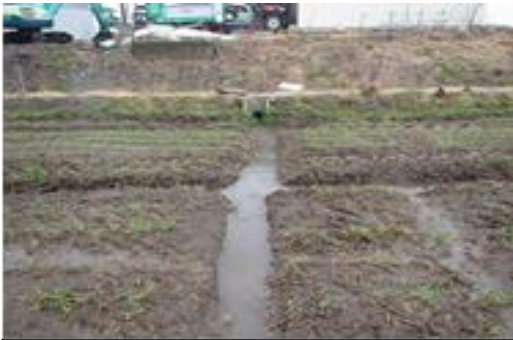
○排水環境の良い例 額縁明きよとほ場内明きよが排水路につながっている
