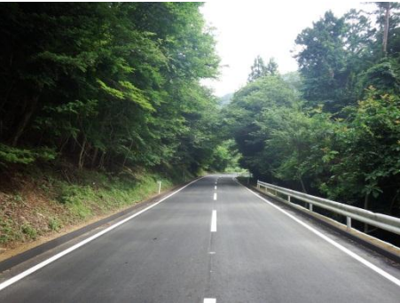
【(一)牡鹿半島公園線 石巻市十八成浜(4)地内】
