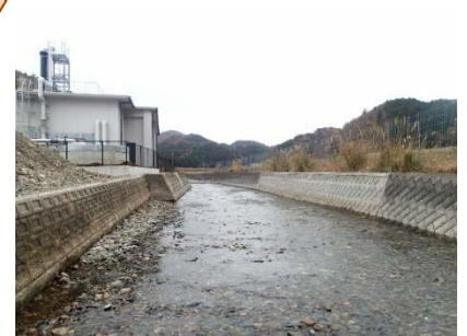
堆積土砂の撤去完了
