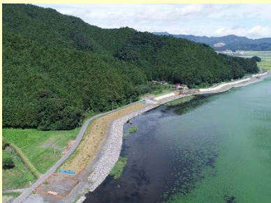
①富士川外1河川災害復旧工事 ②石巻 市針岡地内外 ③地盤改良工事及び樋管 工事を施工中 ④76%
