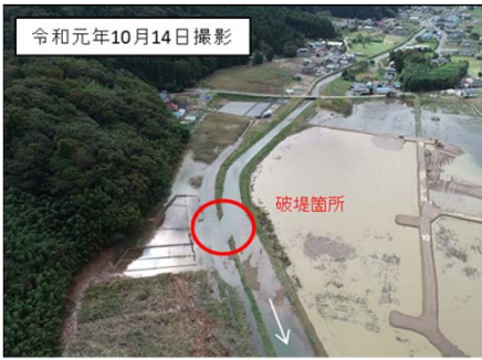
令和元年10月14日撮影 【富士川（破堤）石巻市針岡地内】
