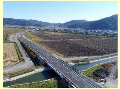
①国道398号石巻バイパスⅡ期工事 ②石巻市大瓜地内 ③全線供用中 側道 部施工中 ④97%
