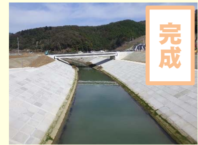
①女川災害復旧工事 ②女川町女川浜地 内 ③H30.10完成 ④100%
