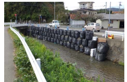
大型土のうにより応急復旧完了
