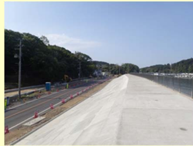
①大原地区海岸災害復旧工事 ②石巻市 大原浜地先 ③天端被覆工事を施工中 ④97%
