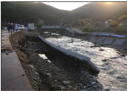
【大原川 石巻市雄勝折下地内】
