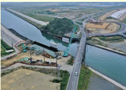
①宮戸道路改良工事 ②東松島市宮戸地内 ③松ヶ島橋の施工中 ④60%
