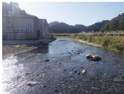
後川の堆積土砂（石巻市谷川浜）
