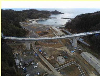
①国道398号相川復興道路事業 ②石巻市北上町十三浜 ③道路改良工事及び橋梁工事を施工中 ④79%
