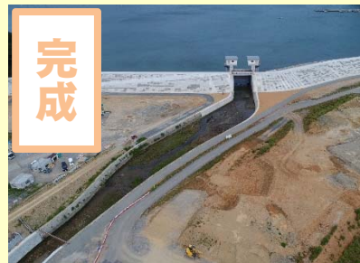
①谷川地区海岸災害復旧工事 ②石巻市 谷川浜地内 ③R1.9完成 ④100%
