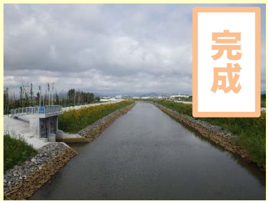
①北北上運河災害復旧工事 ②東松島市 大曲地内外 ③R1.8完成 ④100%
