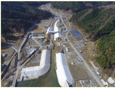
①大原川河川災害復旧工事 ②石巻市雄勝地内 ③護岸工事を施工中 ④75%
