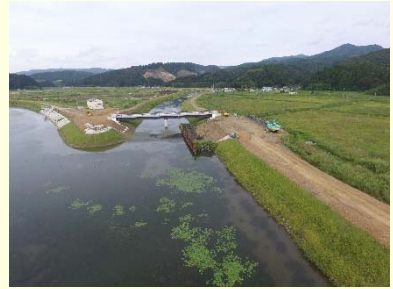
①追波沢川外災害復旧工事 ②石巻市北上町十三浜字江川地内外 ③第二吉浜橋を施工中 ④98%
