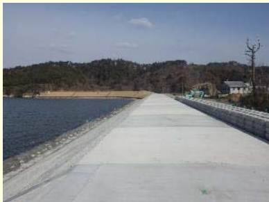
①長石地先海岸災害復旧工事 ②東松島 市大塚地内 ③圧密沈下完了 ④76%
