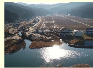
①加茂川河川改修工事 ②石巻市福地地 内 ③橋梁下部工及び樋門・護岸工を施 工中 ④63%
