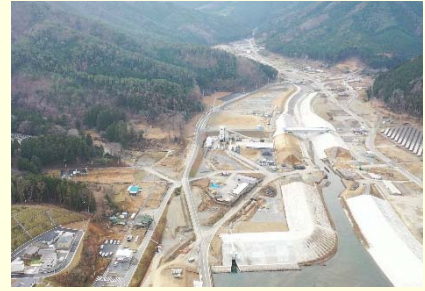
①国道398号雄勝復興道路工事 ②石巻市水浜～味噌作地内 ③味噌作地区で道路改良工事を施工中 ④24%
